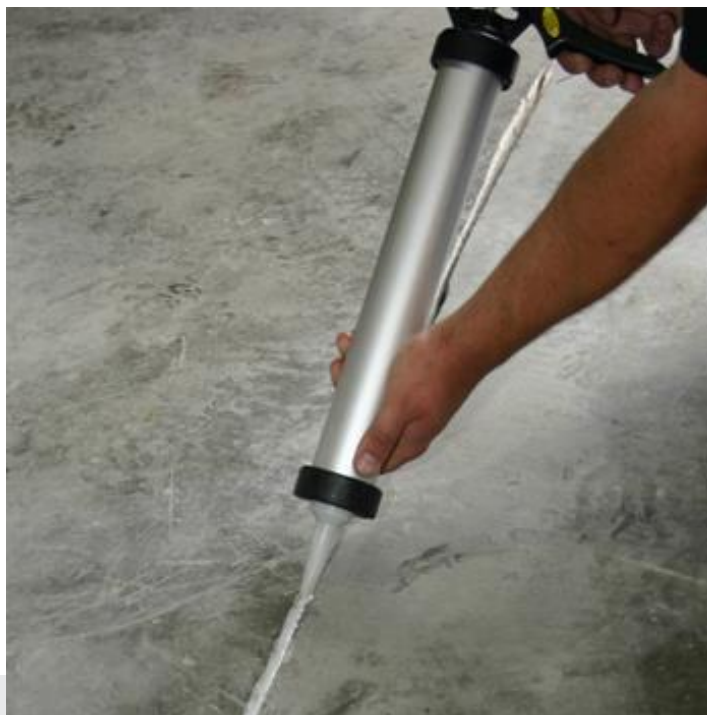
Foto: Aanbrengen voegvulmassa.
